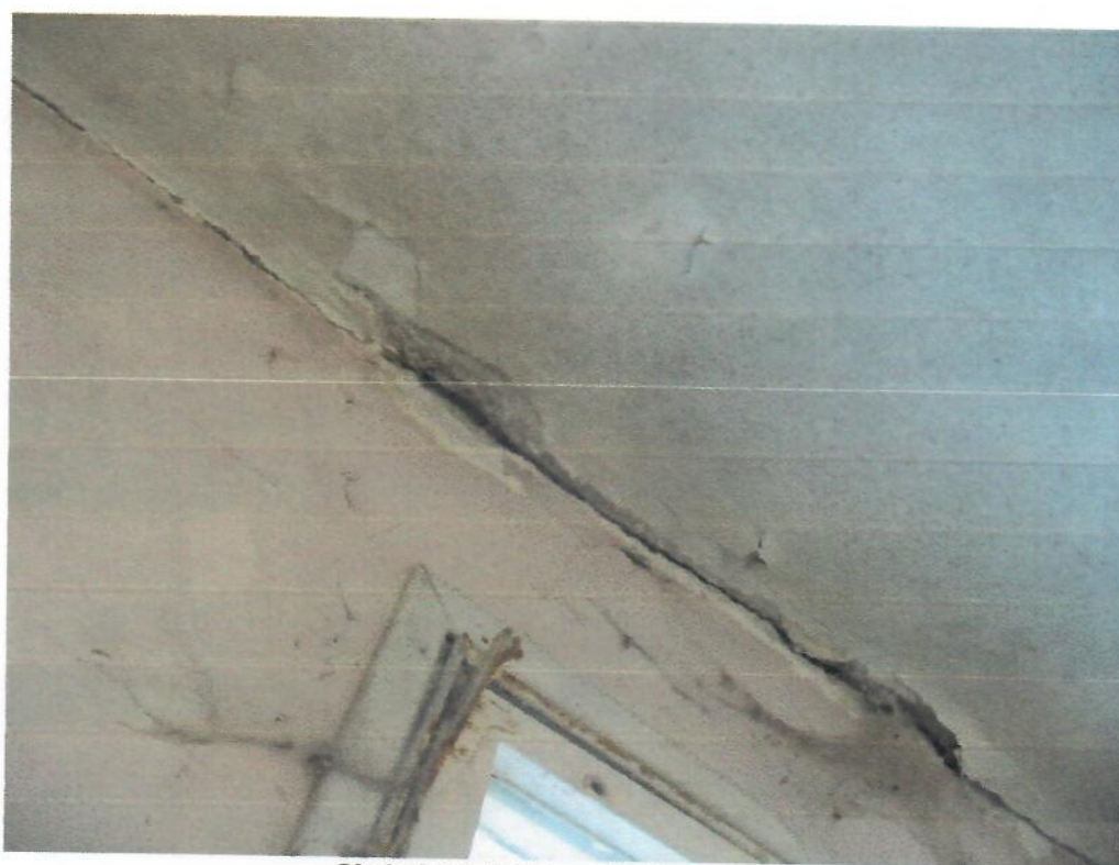
Obrázek 10- Trhlina ve fabionu v 2. NP
